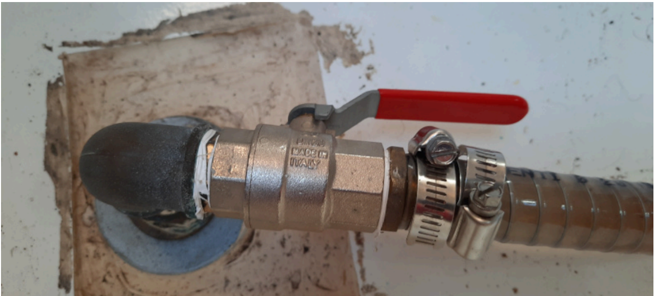
SOSTITUZIONE VALVOLE CON INOX
